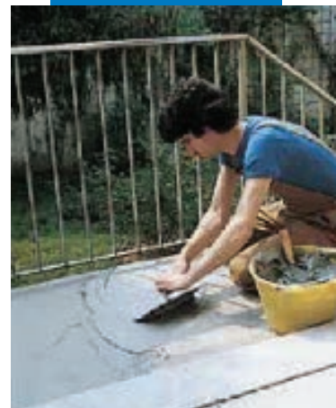
Impermeabilización y posterior colocación con Kerabond+Isolastic
