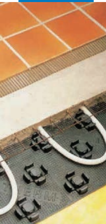
Colocación de cerámica sobre pavimento de calefacción radiante
