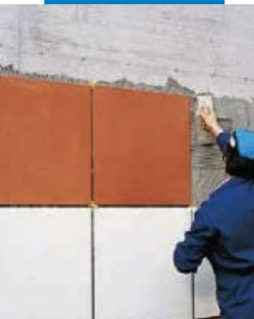
Colocación de grandes formatos con Kerabond+Isolastic
